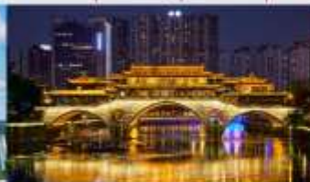
สะพานอันชุน
